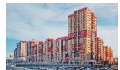
ЖК «Солнечный город», Казань «АК БАРС Строй»
